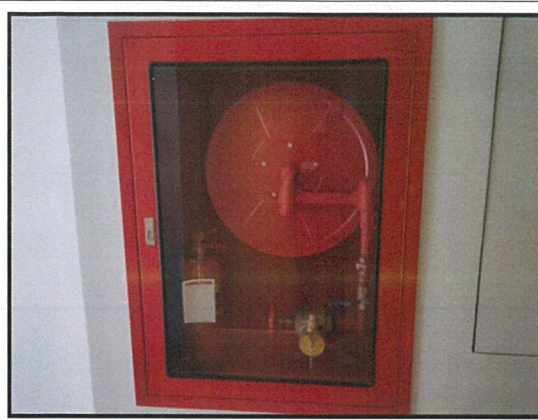
รูปที่ 19 ตู้สายฉีดน้ำดับเพลิงและตู้ดับเพลิง
