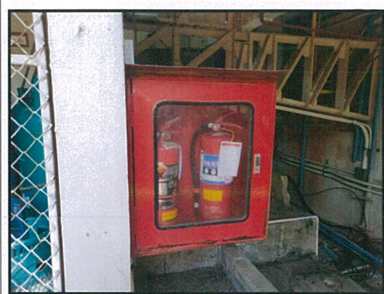
รูปที่ 8 ถังดับเพลิงเคมี บริเวณห้องเก็บก๊าซหุงต้ม
