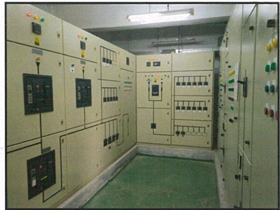
รูปที่ 2 แผงควบคุมไฟฟ้ารวม MDB
