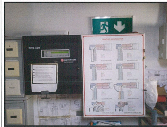
รูปที่ 36 ตู้ควบคุมระบบป้องกันอัคคีภัย
