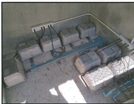
รูปที่ 28 ปุ่มเติมอากาศของระบบบำบัดน้ำเสีย
