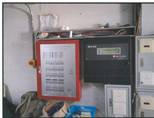
รูปที่ 35 ตู้ควบคุมระบบป้องกันอัคคีภัย
