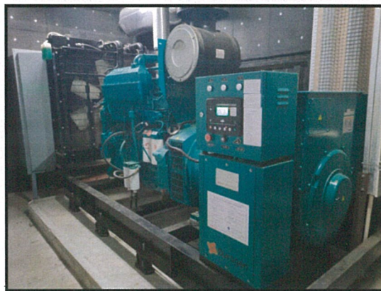
รูปที่ 3 เครื่องกำเนิดไฟฟ้าสำรอง (GEN)
